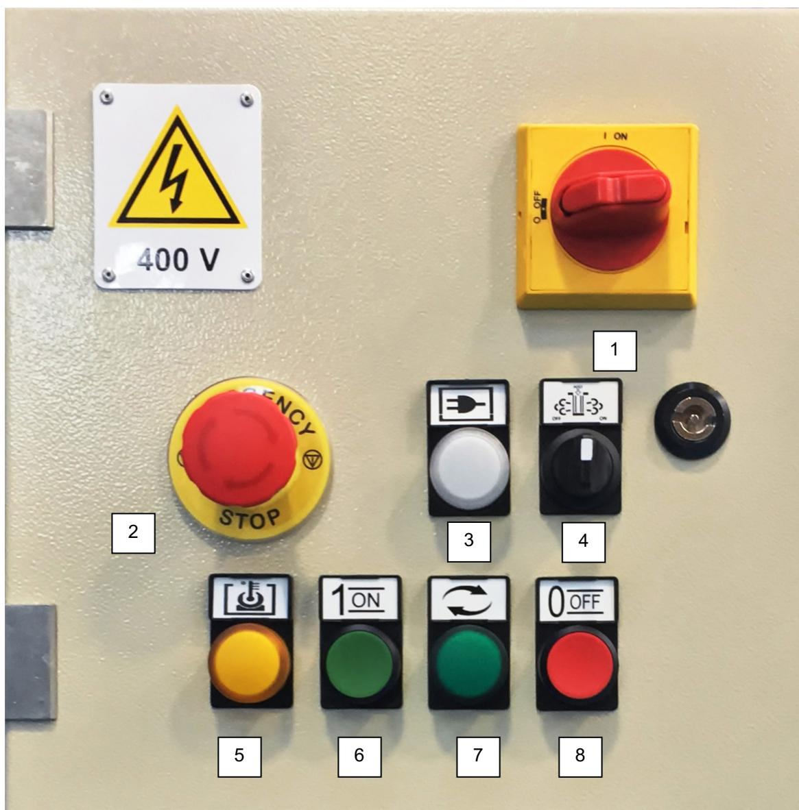
1. I/O Schalter: SCHALTSCHRANKVERSORGUNG
